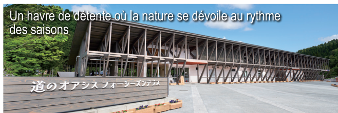
Oasis routière : terrasse des quatre saisons
