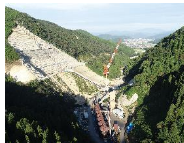
ダム工事現場から 下流方向を望む （越前市街方面）
