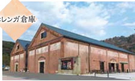
明治期に建設。敦賀港の繁栄ぶりを伝えたレンガ倉庫
