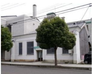
旧大和田銀行本店本館 現・みなと山車会館別館
